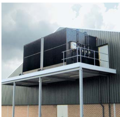
Absorber do oczyszczania powietrza wylotowego wykonany SIMONA® PE 100
