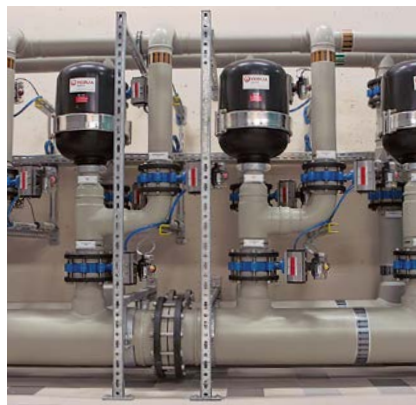
Instalacja filtrowania surowej wody do uzdatniania wody z rur i kształtek SIMONA® PP-H AlphaPlus®
