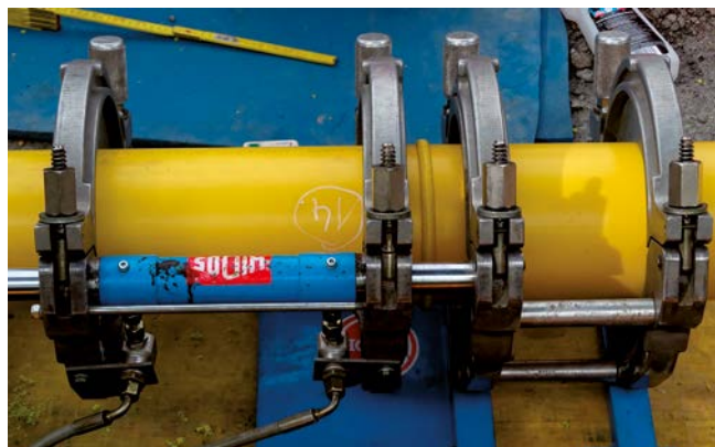
Zgrzewanie przewodu gazowego SIMONA® PA 12
