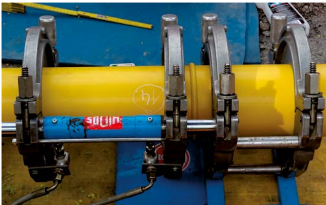
焊接 SIMONA® PA 12 气体管道
