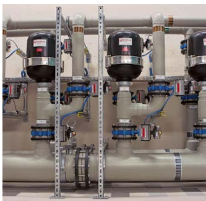
用于水处理的管道水过滤装置，采用 SIMONA ® PP-H AlphaPlus ® 管材和成型件
