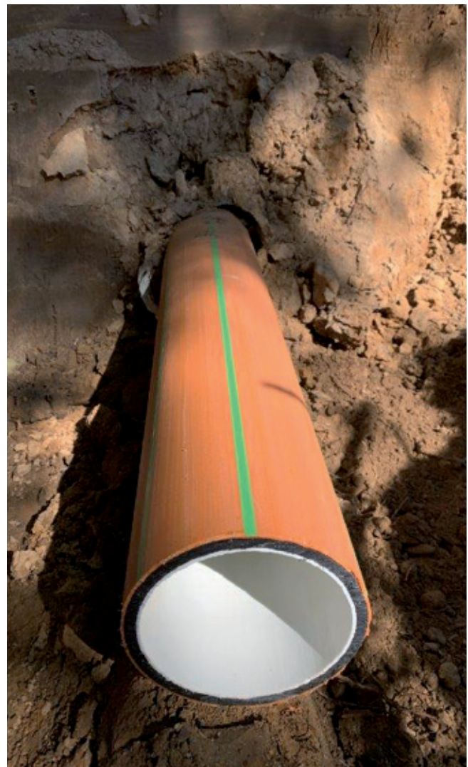
New pipe SIMONA® PE 100 SPC AP-Line OD 200 x 11.9 SDR 17
