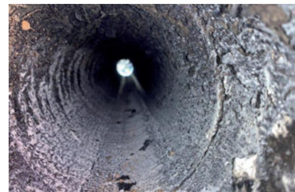
Alte Asbestzementrohrleitung DN 150 mit beschädigter Innenschicht
