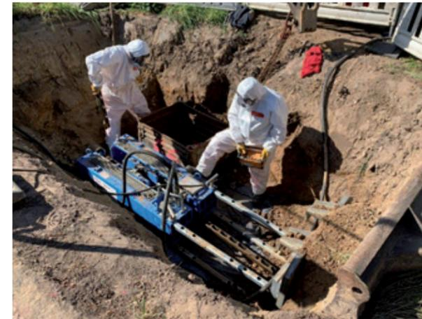
Maschinengrube mit statischer Berstlafette Grundoburst 400 G beim Einziehvorgang; Vorgeschriebene Schutzbekleidung der Bediener gem. TRGS
