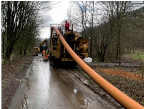
Einbau der Rohrleitung mittels Grabenfräsen
