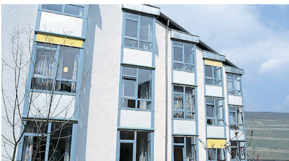
SIMONA® PVC Platten werden zu hochwertigen Sandwichelementen für den Bau von Fassaden weiterverarbeitet.
